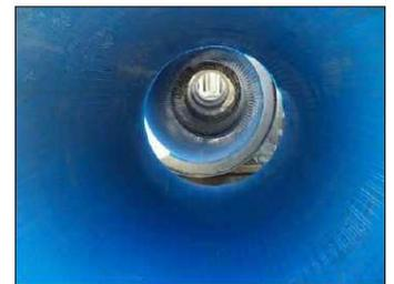
Rivestimento interno in liner polietileno ad alta densità (HDPE)
